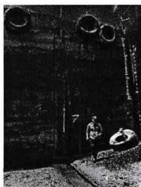
Ảnh 7 – U7: Trụ đầu ụ phía hạ lưu Nứt rộng
